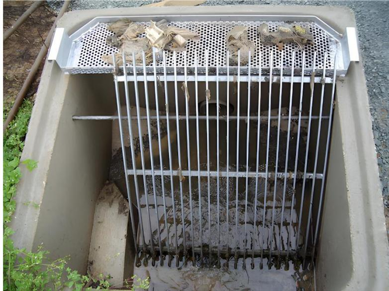
**Figure 10** : Un tamis métallique pour éliminer les grosses particules.
