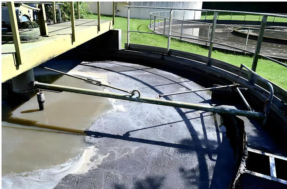
**Figure 12 :** Les racleurs montrent l'élimination des graisses
