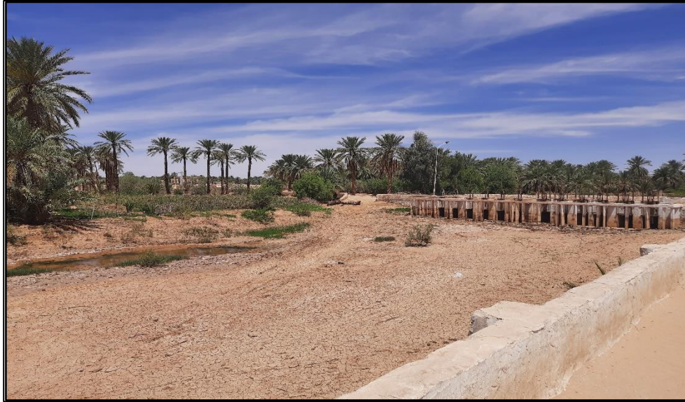
Photo 1 : Digue de dérivation de la crue de l'Oued Zegrir
