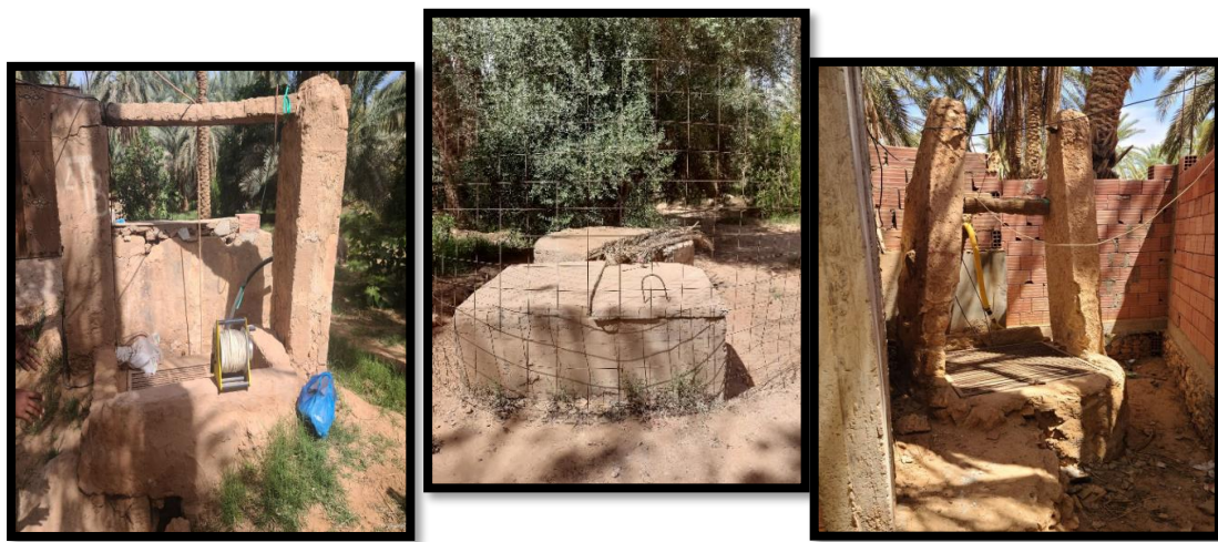
Photo 3 : Des photos montrant les trois puits de prélèvement d'eau
