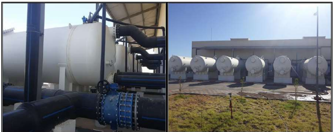
Figure II.7. Unités Filtre à sable.
