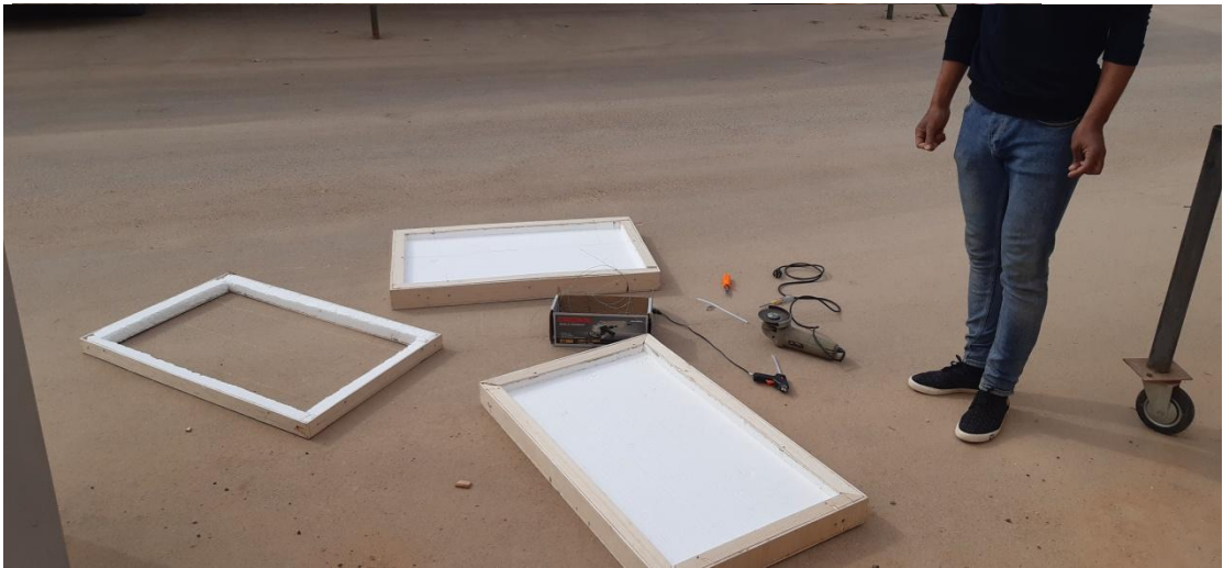
Figure II-3: Après l'installation du polystyrène
