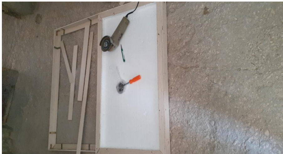
Figure II-2: Panneau en bois après découpe et pose
