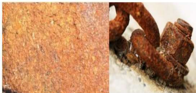
Figure I.3 Exemples de corrosion uniforme
