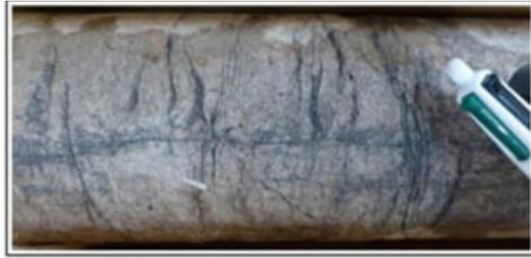
Figure II-5 Exemple des fractures verticales partiellement ouvertes dans une carotte.
