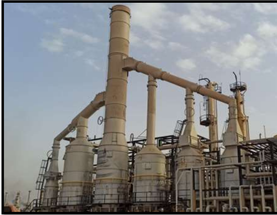
Figure III-4: photo réelle de four de l'unité de reforming catalytique ou niveaux de la nouvelle raffinerie de Hassi Massoud.
