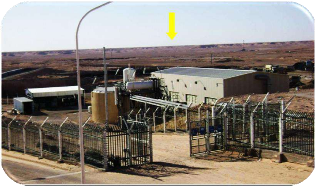
Figure III. 5 : Station de déshuilage du champ de Haoud Berkaoui.
