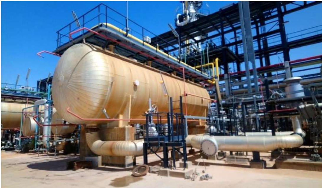
Figure I.7: Séparateur diphasique
