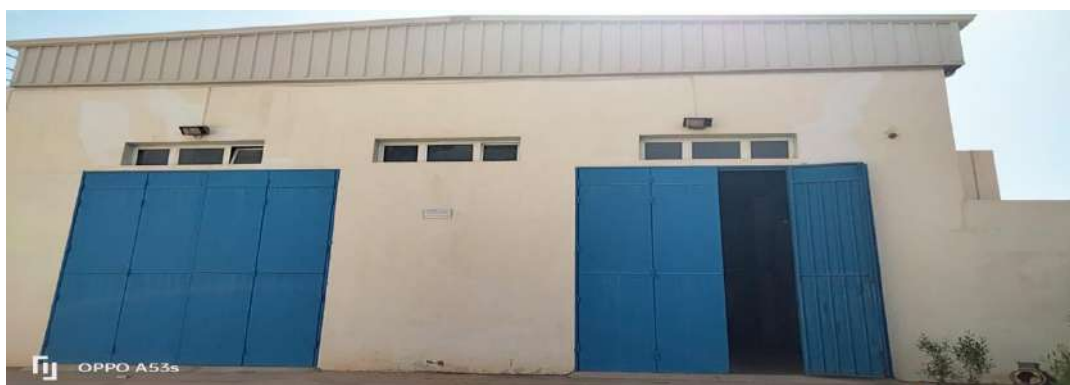
Figurer 2 Construire le traitement de l'extérieur
