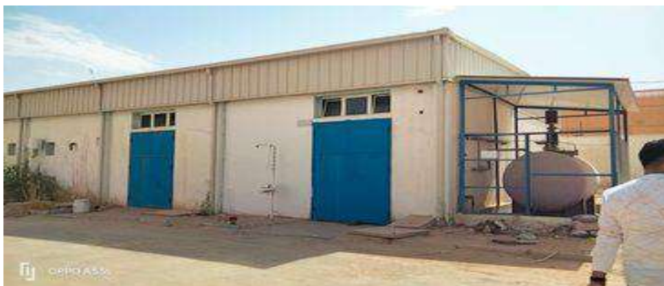
Figurer 4 Bâtiment de chloration de l'extérieur
