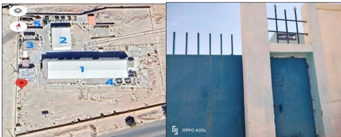
Figurer 24 : Image prise par satellite et La façade avant de Station de dessalement
