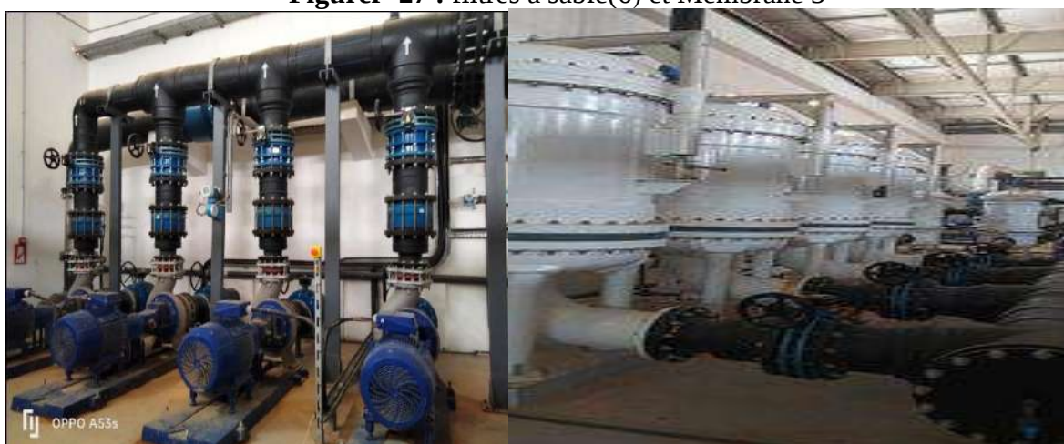
Figurer 28 : Pompes haute pression et filtre cartouche
