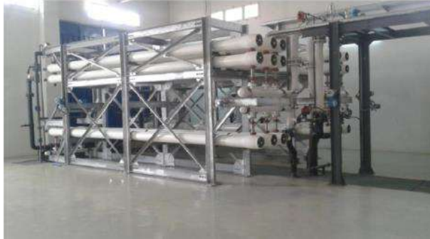
Figure III.10: Unité d'osmose inverse
