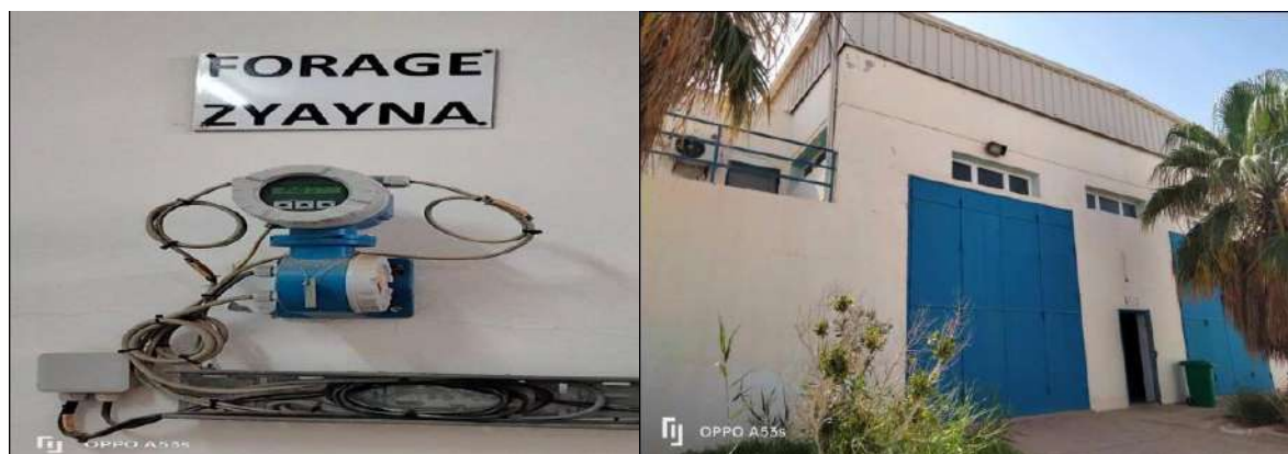
Figurer 18 Forage et Bâtiment de traitement
