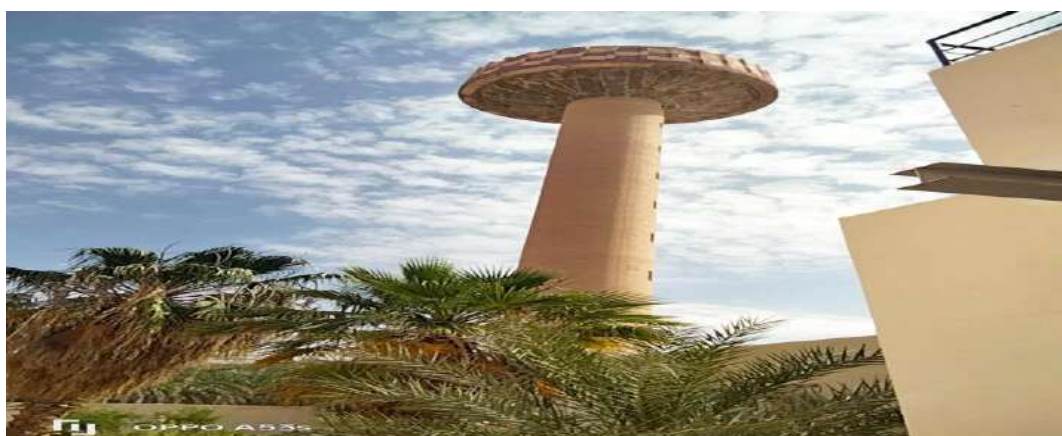
Figurer 9 Le Château d'eau à la station de GHARBOUZ
