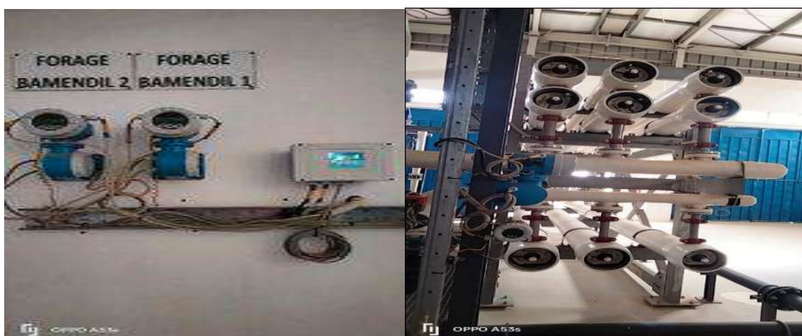
Figurer 14 FORAGE 1et 2 et les membranes 9 (6 au-dessus et 3 en dessous)
