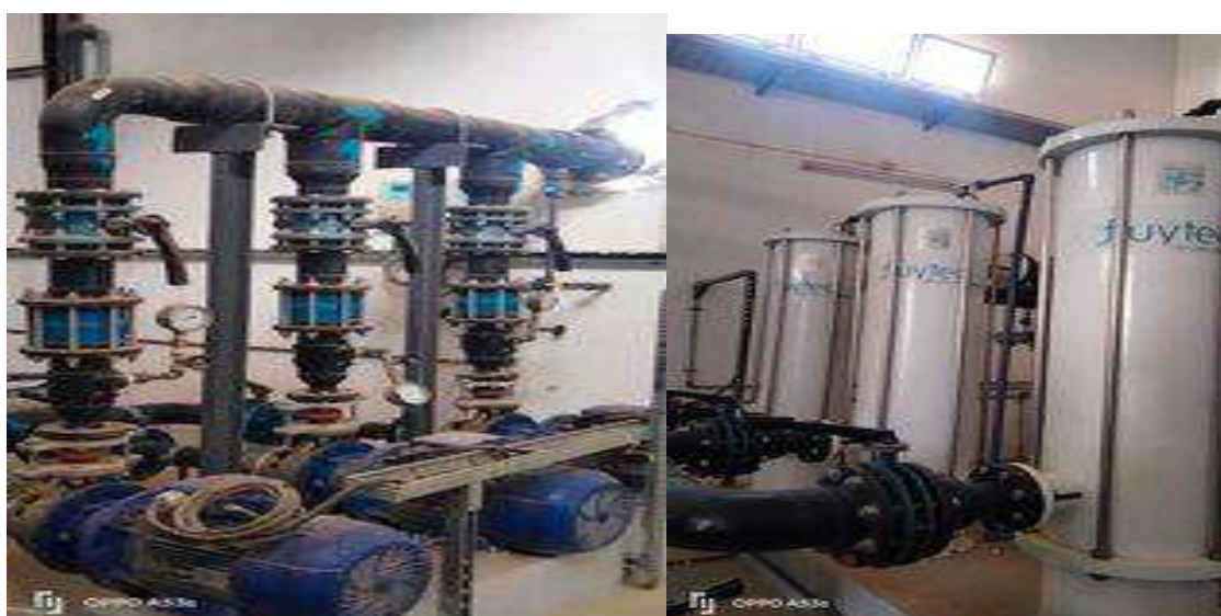
Figurer 11 Pompes haute pression et 3 filtres à cartouches
