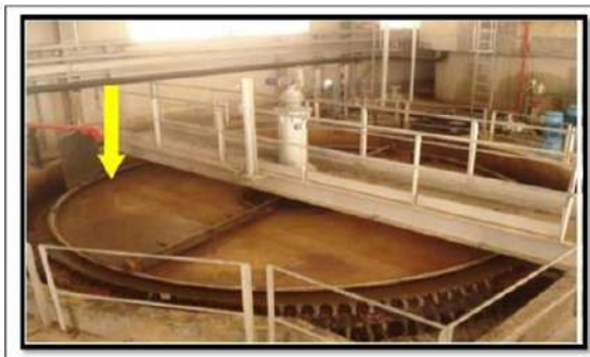
Figure 7: Cuve d'eau traitée S-106
