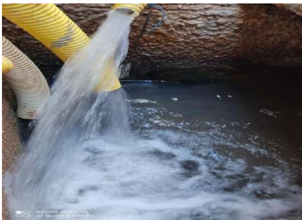
Rejet de saumure
