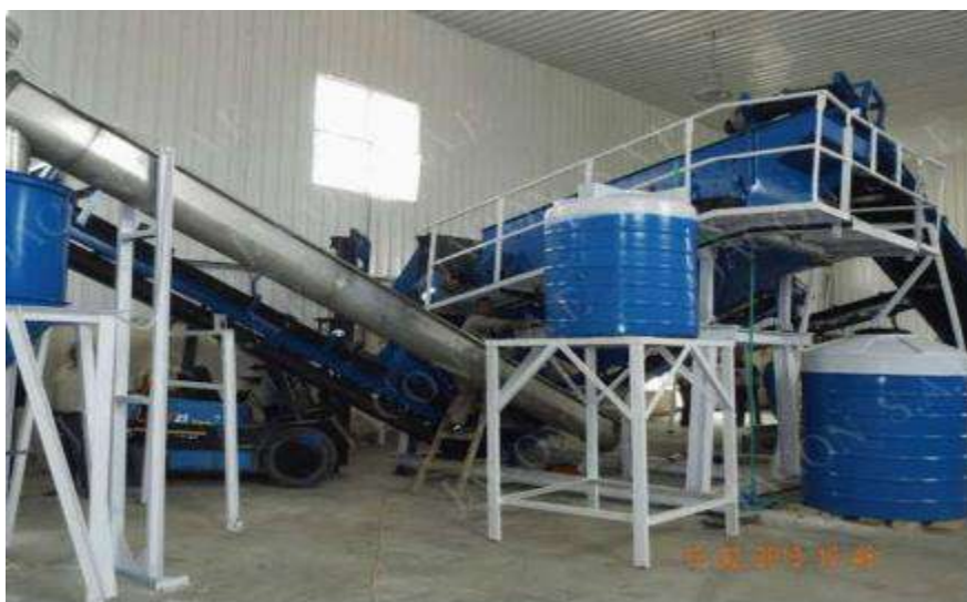
Figure III.7 : usine de sel
