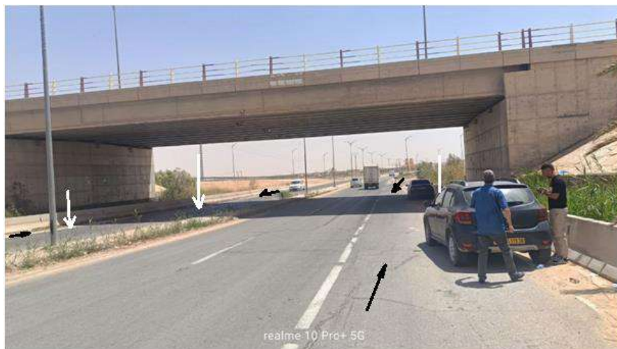
Figure (3. 26) : Endroit d'emplacement des puits d'infiltration au niveau du pont à El Khefdji. Les flèches blanches indiquent l'endroit des puits. Les flèches noires indiquent le sens d'écoulement des eaux pluviales.
