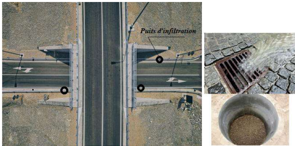
Figure (3. 25): Disposition des puits d'infiltration au-dessous du pont (à gauche). Avaloire et bassin d'infiltration (à droite)
