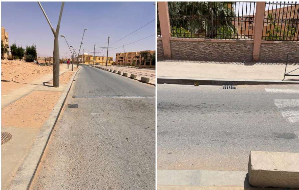
Figure (3. 16): Avaloirs collectant des eaux pluviales des routes vers le réseau d'assainissement
