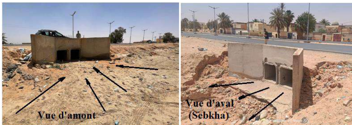
Figure (3. 18): Arrivée des eaux de ruissellement de surface de la ville vers la sebkha. Point de rejet à côté du post de la gendarmerie nationale
