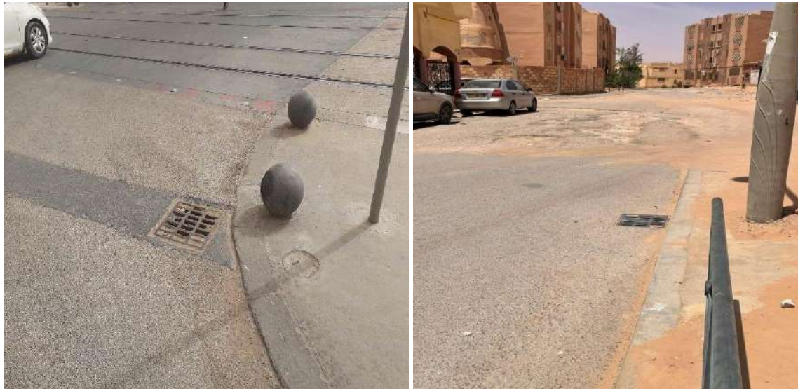
Figure (3. 15): Avaloirs collectant des eaux pluviales durant les pluies.
