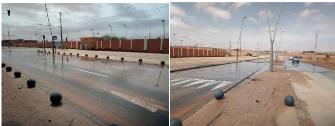
Figure (3. 19): Stagnation des eaux pluviales au niveau de la route et des lignes de tramway à côté de la gare routière de Ouargla.
