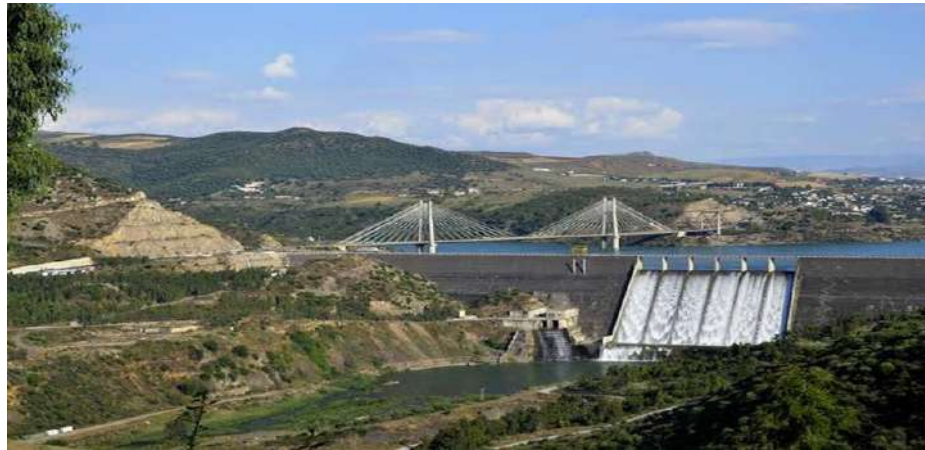
Figure I-3: barrage en béton (Barrage de Beni Haroun à Mila).
