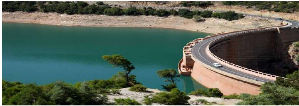
Figure I-2: Exemple d'un Barrage voûte.
