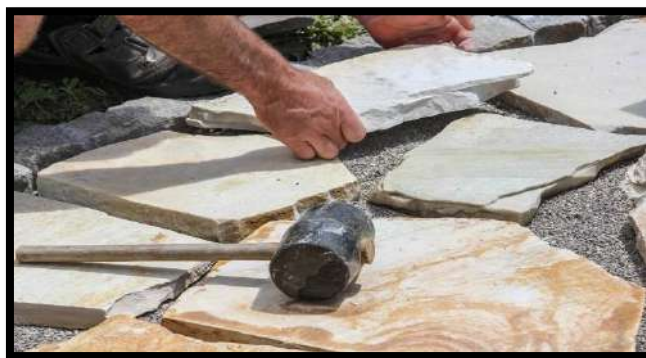
Photo (I.4) : Pierre Naturelle Taillée Au Cours De Construction
