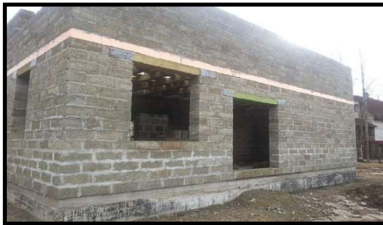
Photo (I.14) : Maison En Briques En Liant De Papier En Cours De Construction
