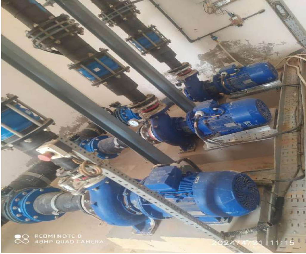
صورة V6: للمضخات المؤدية نحو أبراج التوزيع وأحواض التوزيع
