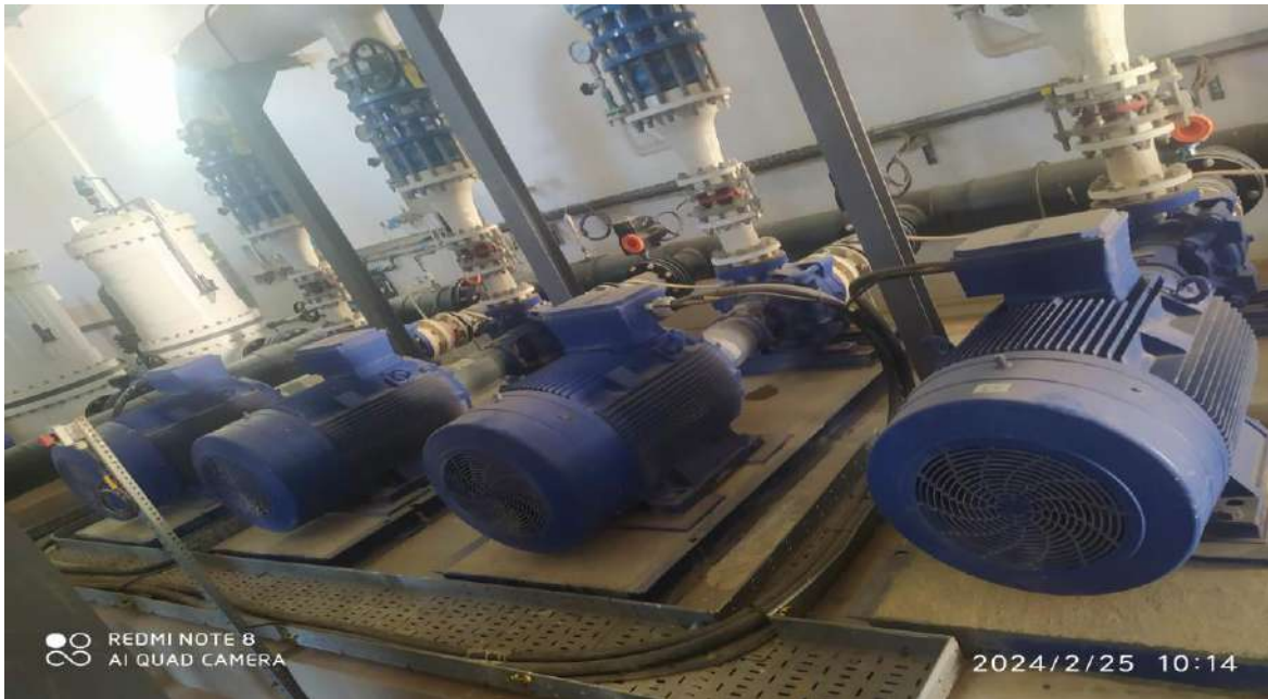
صورة V4 توضح مضخات التغذية لأجهزة التناضح العكسي
