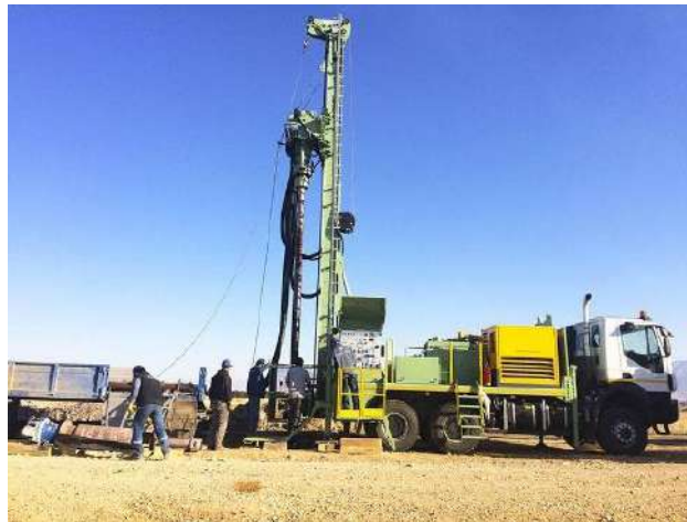
Figure II.01 : appareil de forage par battage
