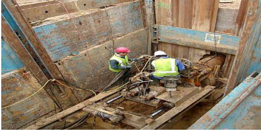
Figure I.04 : Forage horizontal d'une source
