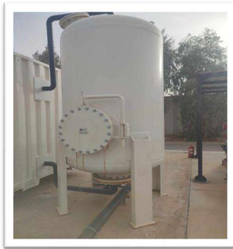
Figure II-8: Filtre à sable
