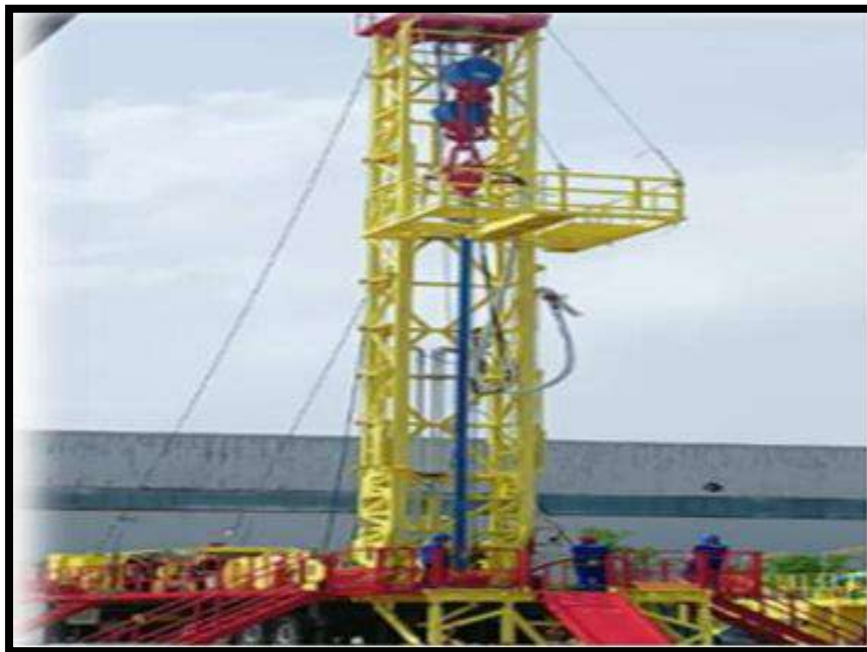
Photo N°02 : Le mat de forage. [3]
