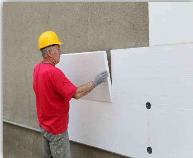
Figure III.14. La manière de montage des panneaux sur mur [24]
