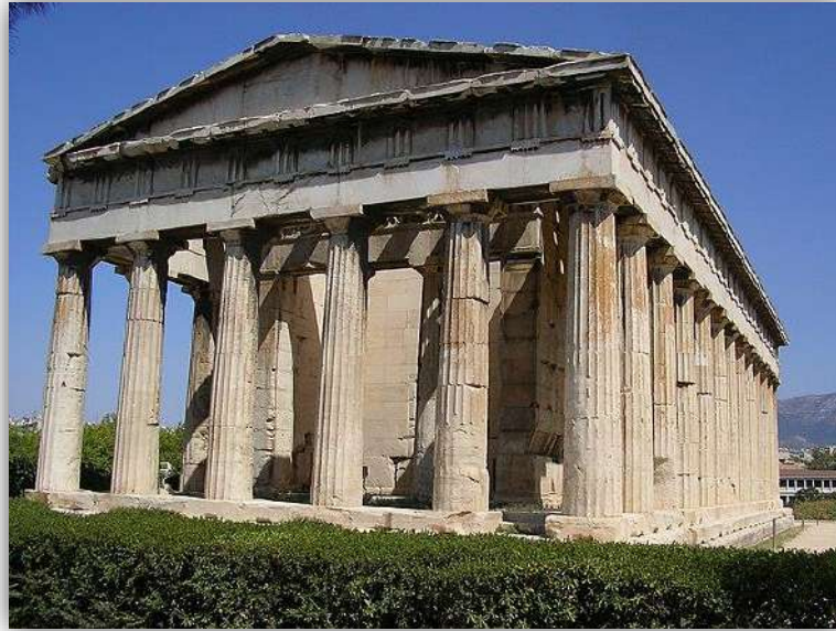
Figure I.2. Façade à l'époque grecque.[3]
