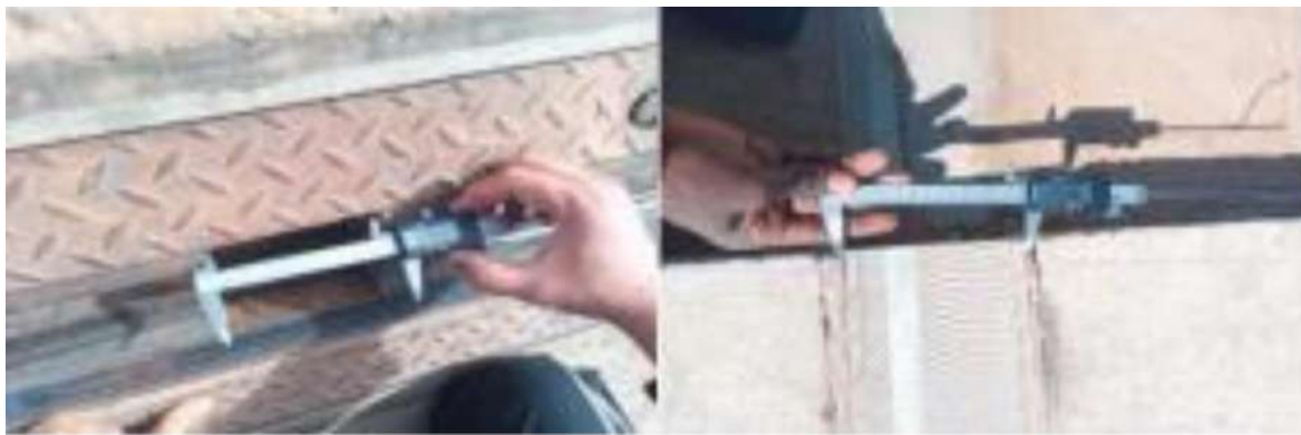
Figure 3-1 : Mesurez l'écart et le joint du pont.
