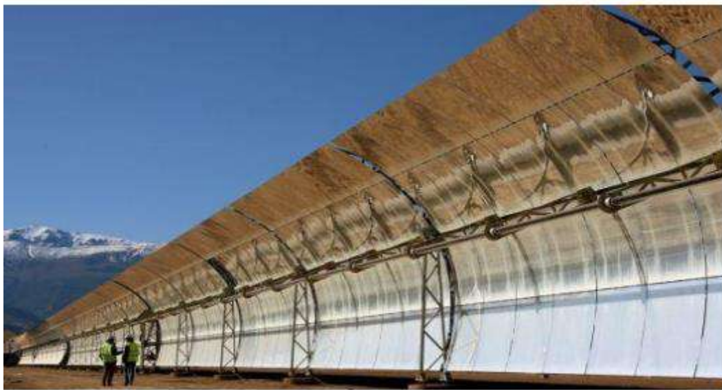
Figure I.3 la plus grande centrale solaire thermique d'Europe en Espagne [4]
