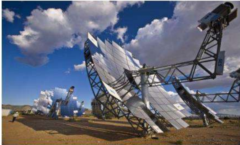
Figure I.5 Paraboles solaires Dish-Stirling à Albuquerque, Australie [4]
