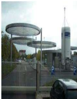
Fig.1.6 : Station-service cryogénique Linde cryogénique
