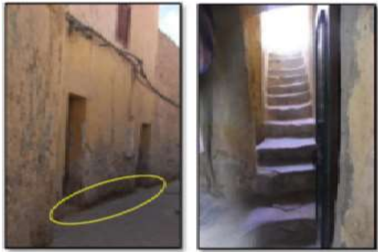
Figure 1-10 Entrées de maison, seuil et escalier menant de la rue à lā'lli (Lebsir, 2016).
