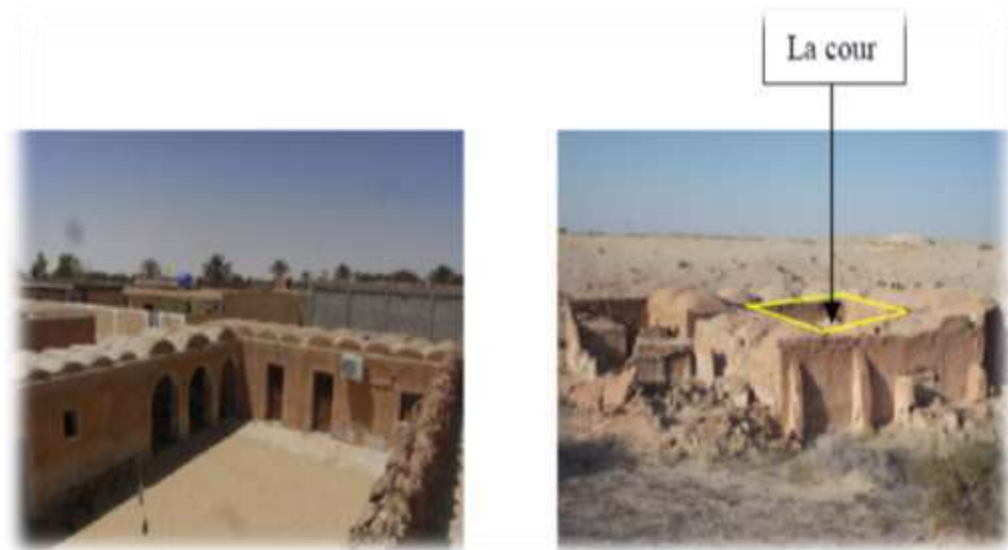
Figure 1-13 La cour dans une maison villageoise et une maison rurale à Guemar (Lebsir, 2016).
