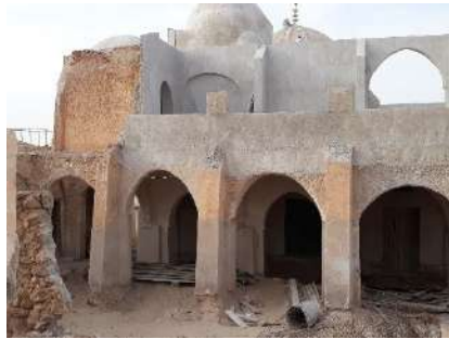
الشكل 31.I ترميم الزاوية التجانية بالجبس 2022.
