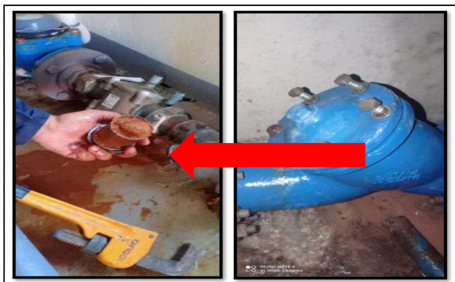
Figure II.6 : Aperçu sable sur filtre à tamis
