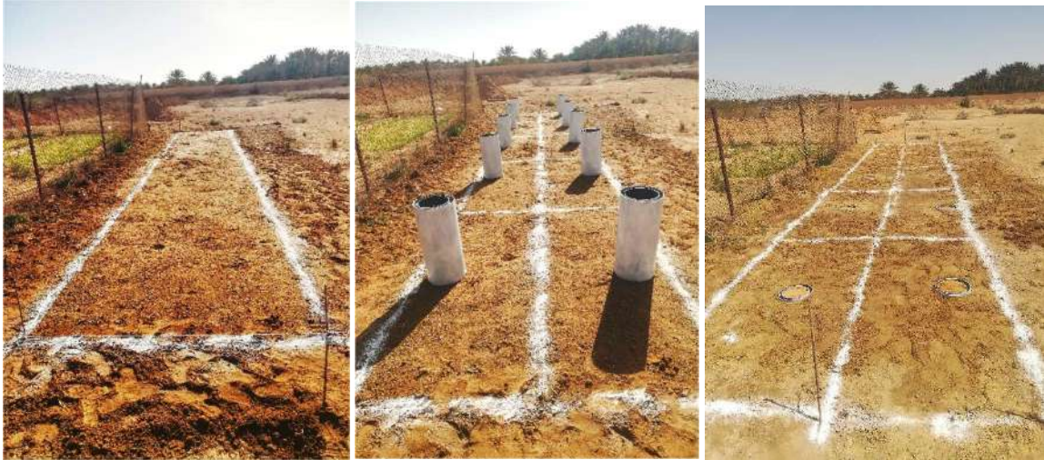
Figure 28. Installation des lysimètres sur le champ expérimental
