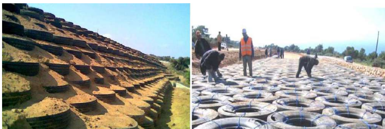
Figure III. 7. Chantier expérimental Pneusol à Bou-Smail (à gauche) [88] ; Ouvrage de Mostaganem RN11 (à droite) [87]
