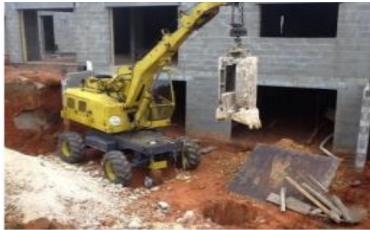
Figure I-6: Forage par havage
