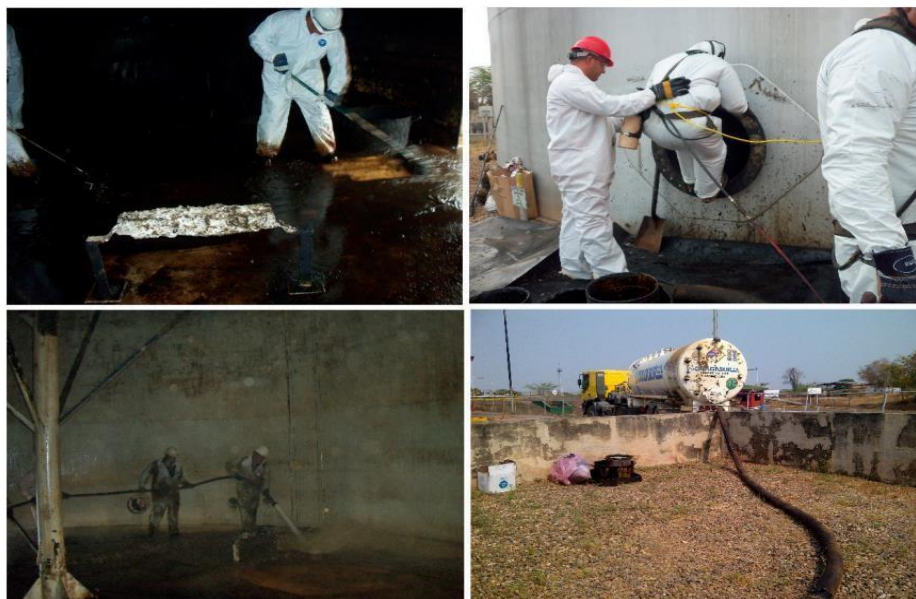
Figure II.4 : Nettoyage manuel du réservoir de pétrole brut [43]
