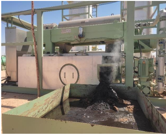
Figure III.18 : rejet de solide de centrifuge
