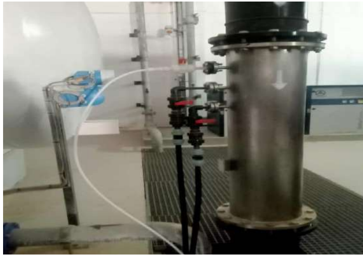
Figure III.5 : les points d'injection
