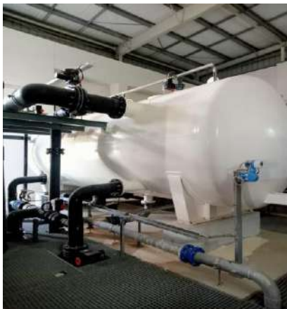
Figure III.6 : les filtres à sable de la station de IFRI GARA S5
