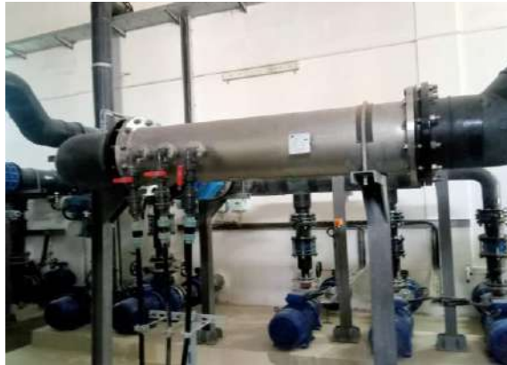
Figure III.9 : les points d'injection
