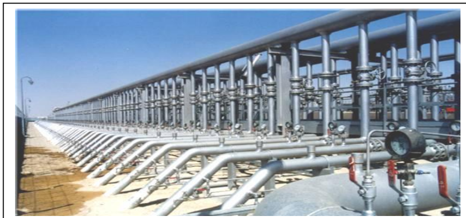
Figure II.3 Collecteur de puits "manifold"
