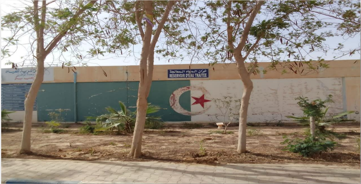
Image 10 : Réservoir d'eau traitée
