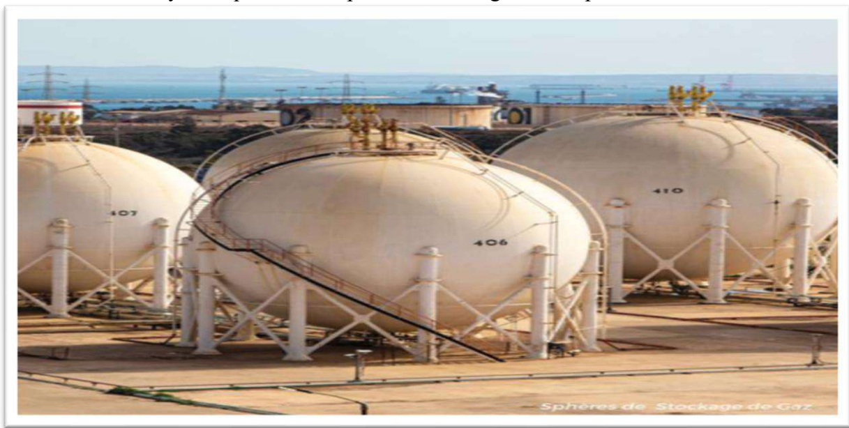
Figure I-2: Les sphères de stockage de gaz
