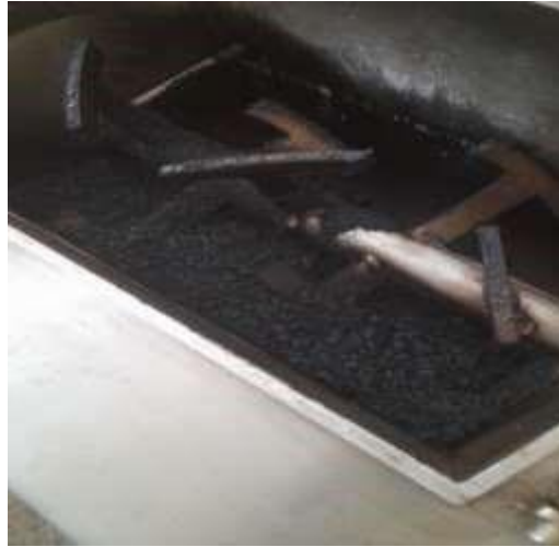
Photo 4.1 Mélange d'un enrobé bitumineux à chaud Bitumineux
