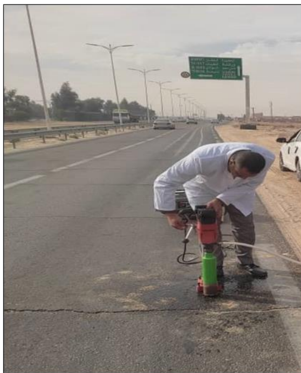
Image III.1: Réalisation du forage
