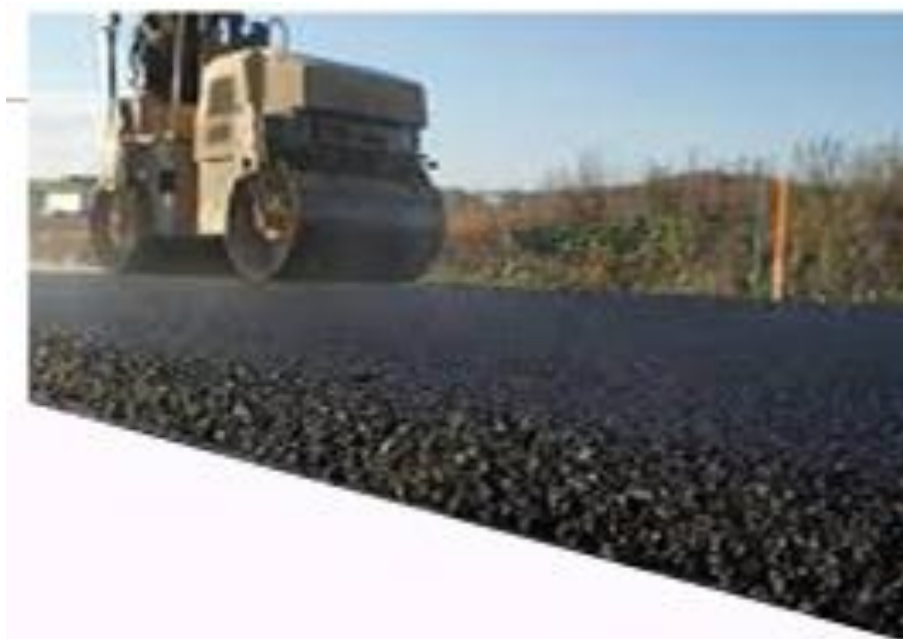
Figure IV.3: Compactage de bitume à chaud
