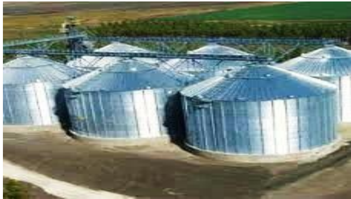
Figure 06 - Exemple des Silos métalliques (Kara, 2021).
