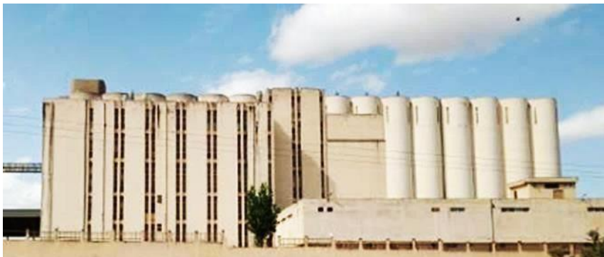
Figure 07 - Exemple d'un Silos en béton armé (Kara, 2021).
