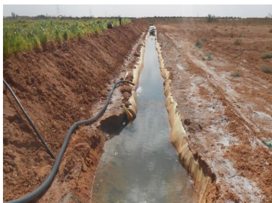
Photo 11: Irrigation par les eaux de drainage
