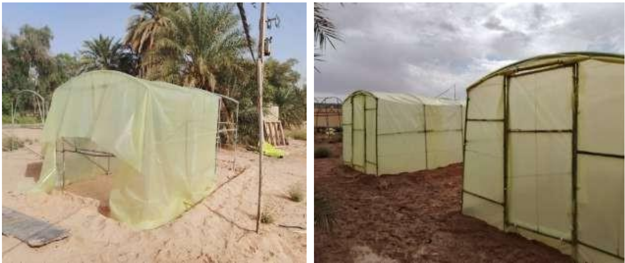
Photo 01: Installation des serres
