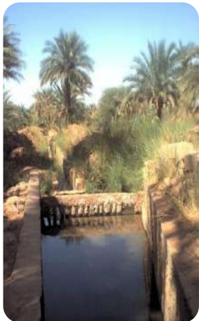
Système de partage d'eau, sous forme de peigne, appelé « Kasria » Foggara de Tamentit.
