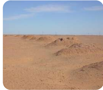
Puits d'aération des foggaras
