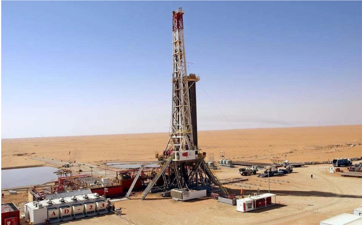
Figure I.12: Vue de l'appareil de forage
