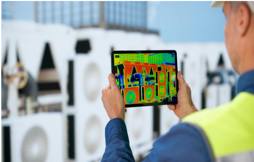
Figure 2.6.:Inspection thermique d'un système de réfrigération et de climatisation (HVAC) montrant la détection des anomalies, la distribution thermique et l'optimisation de l'efficacité énergétique.
