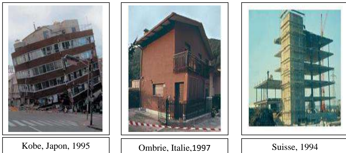
Figure I.14 : Endommagement des structures causé par le phénomène de torsion [22].
