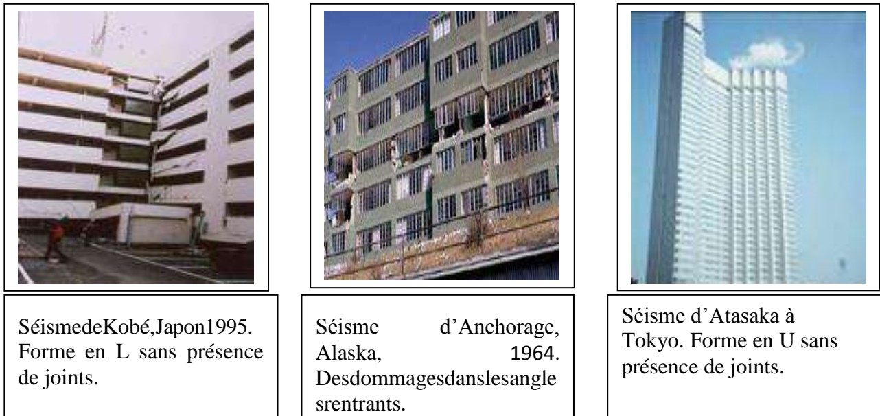
Figure I.10 : Les dégâts observés à la jonction des pans dans les structures composées [22].
