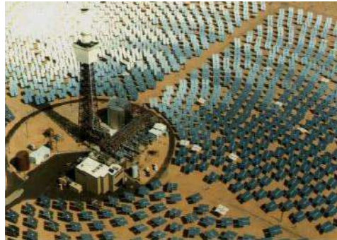
الشكل (2-8): يوضح نظام برج الطاقة المركزي [10، 11]
