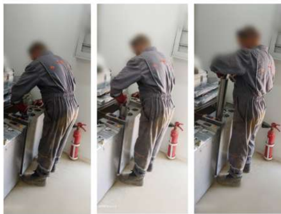
FIG. 2.21 – Placement des canisters à l'intérieur des bains électriques.
