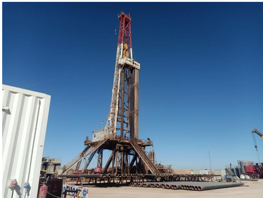
Figure 3: Image réelle de l'appareil de forage ENF-39 sur le site du puits BRSN-1
