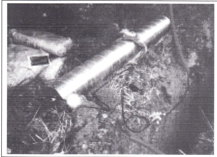
Fig II.12 : installation d'anode sur site.
