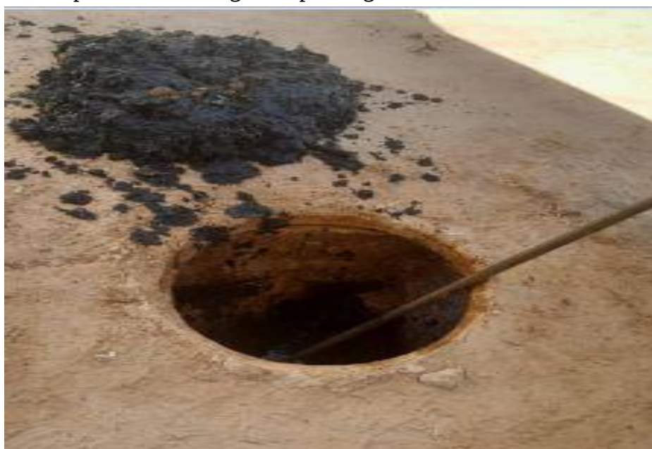
Figure III.02: Nettoyage préventive d'un regard à lala mana Témachine.
