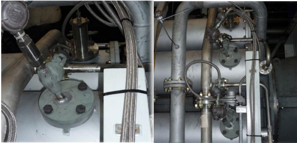
Figure II. 8. Détecteur de flamme ultraviolet [11]
