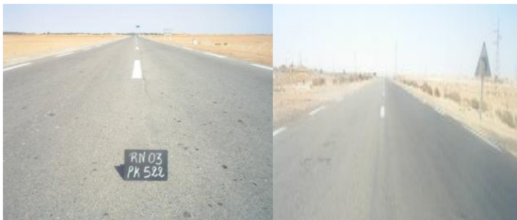
Figure I.7 : Etat actuel de la route Largeur de chaussée en section courante : varie de 7.2 à 7.7 m Largeur d'accotement : varie de 1.8 à 2.8 m
